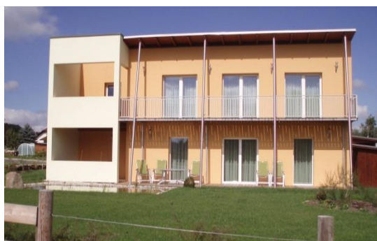
Südseite eines Passivhauses große Glasflächen
